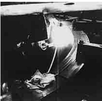
Рис. 1. Многопроходная сварка лепестков полусферы корпуса ГА из титанового сплава ВТ6
