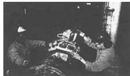
Рис. 1. Установка моторизованного сканера на стыковой сварной шов в условиях трубоукладочной баржи
