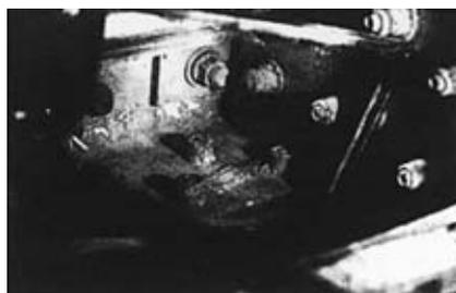
Рис. 6. Коррозия внутренних соединений
