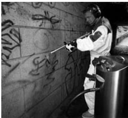
**Рис. 9. Очистка поверхности сухим льдом**
